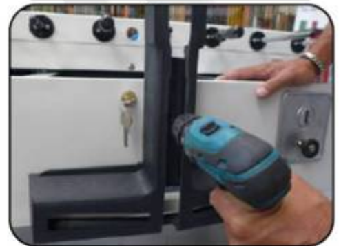
...von hinten mit Mutter/ Unterlegscheibe fixieren...Mittelloch bohren und Schraube...
